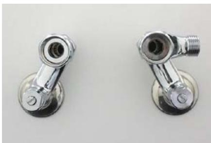
使用状況に応じて各クランクにソケットを取付け向きを調整します。
