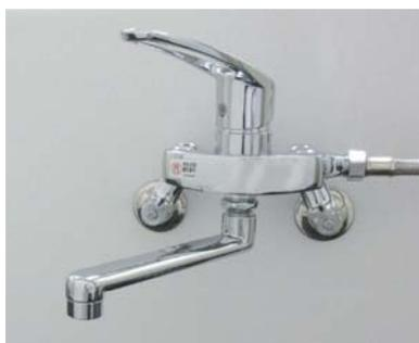
混合栓を再度取付けて、新たにブレードチューブ等で配管を分岐すれば完成です！
